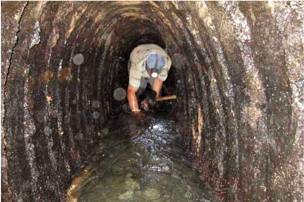
Obr. 4 Oprava stien kanátu (Birjand).
