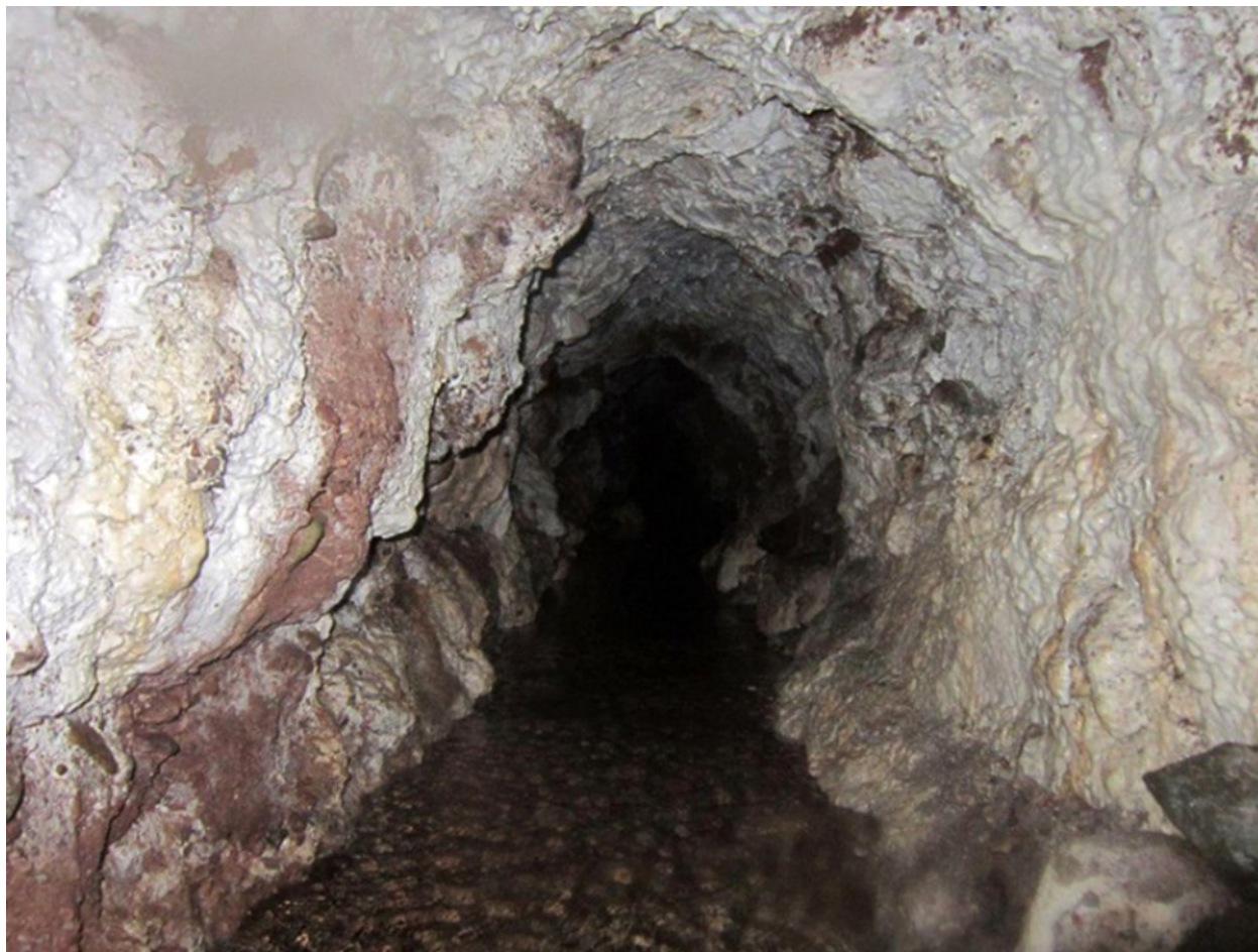
Obr. 3 Podzemný vodný tunel v Birjande.
