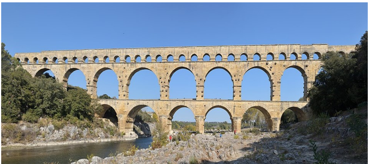
Obr. 3 Most Pont du Gard.
