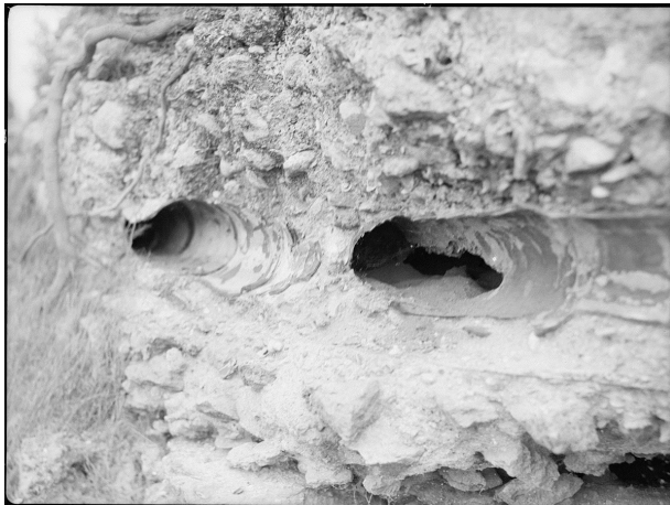
Obr. 8 Keramické potrubie akvaduktu v Cesarei.
