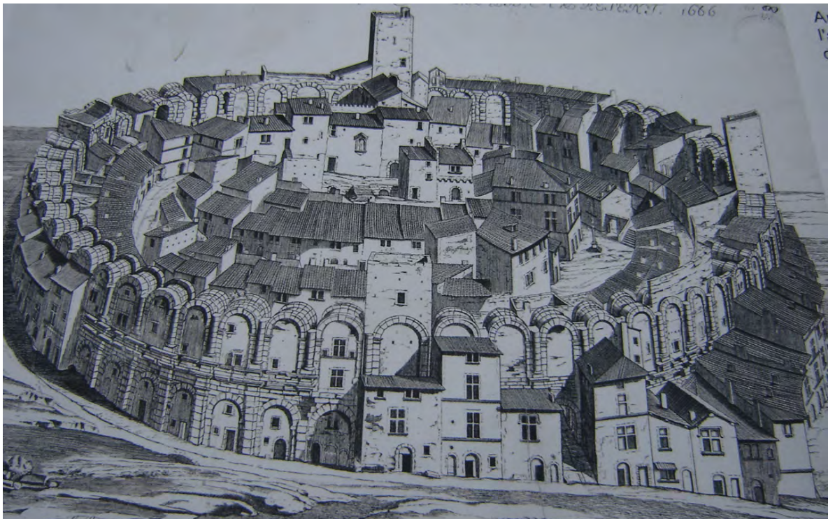
Obr. 4 Amfiteáter v Orange (FR) v stredoveku. Foto: Erik Hrnčiarik.
