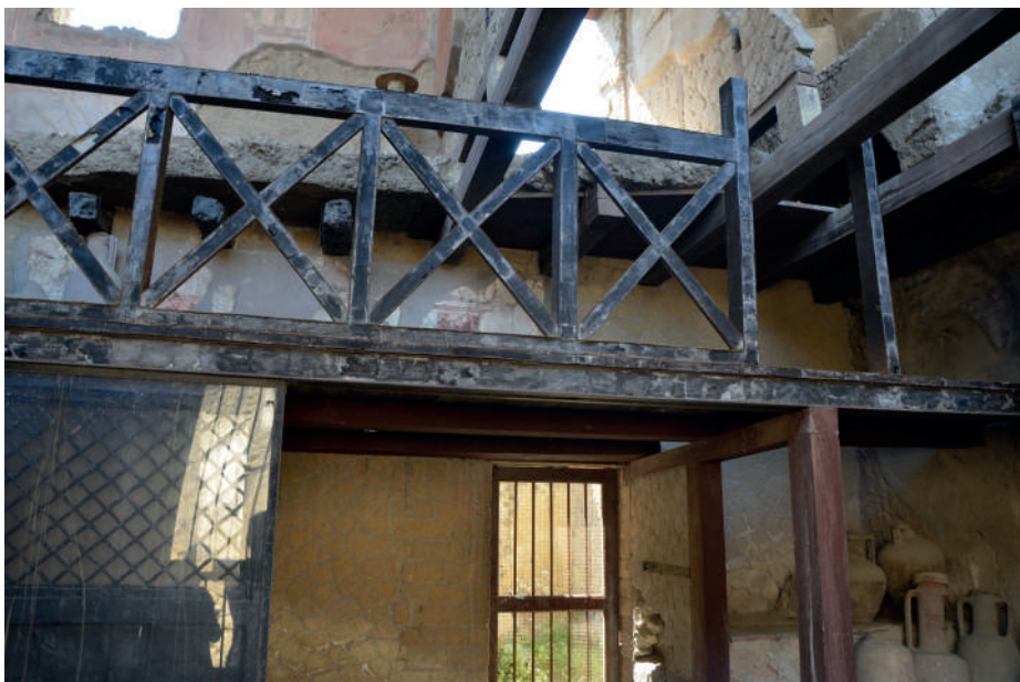
45 Dom Neptúna a Amfitrité, Herculaneum. V mnohých budovách v meste sa zachovalo druhé poschodie. Foto: Erik Hrnčiarik.
