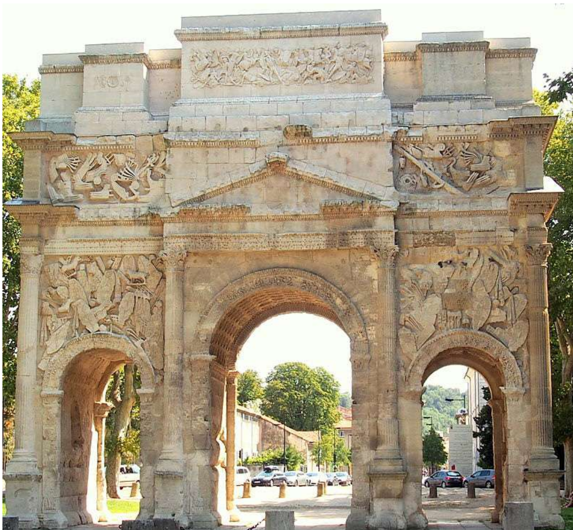
Obr. č. 4 Severná fasáda oblúku v Orange
