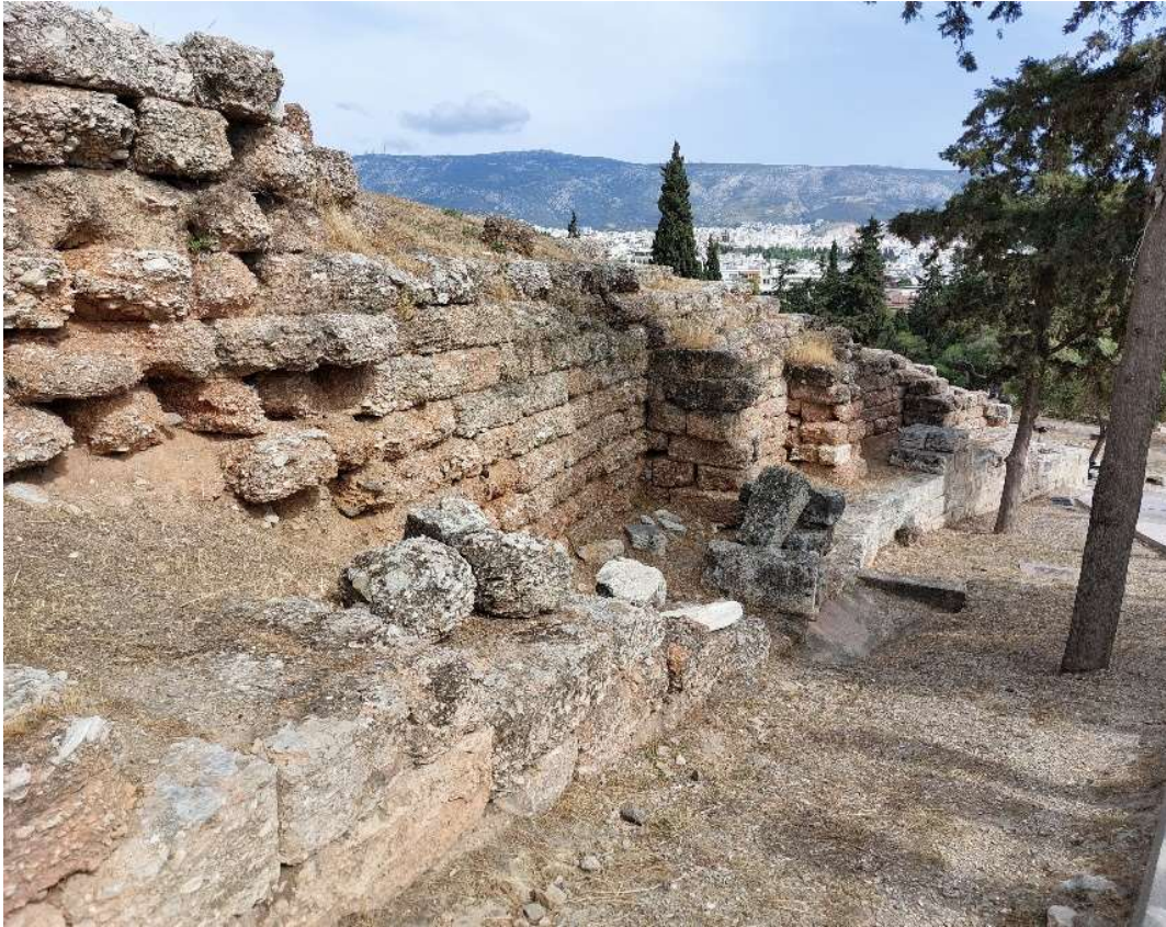
Obr. 4: Časť západnej opornej steny (Autor: A. Igaz).
