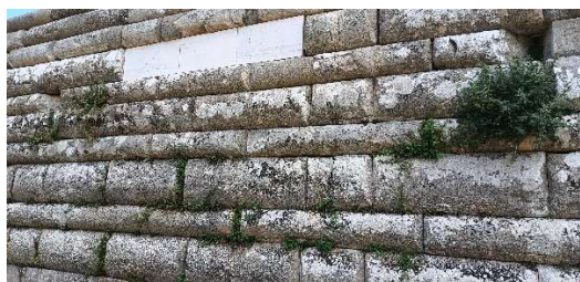
Obr. 6: Pohľad na stenu odeonu vystavanú technikou opus pseudoisodomum (Autor: S. Tomaščík).
