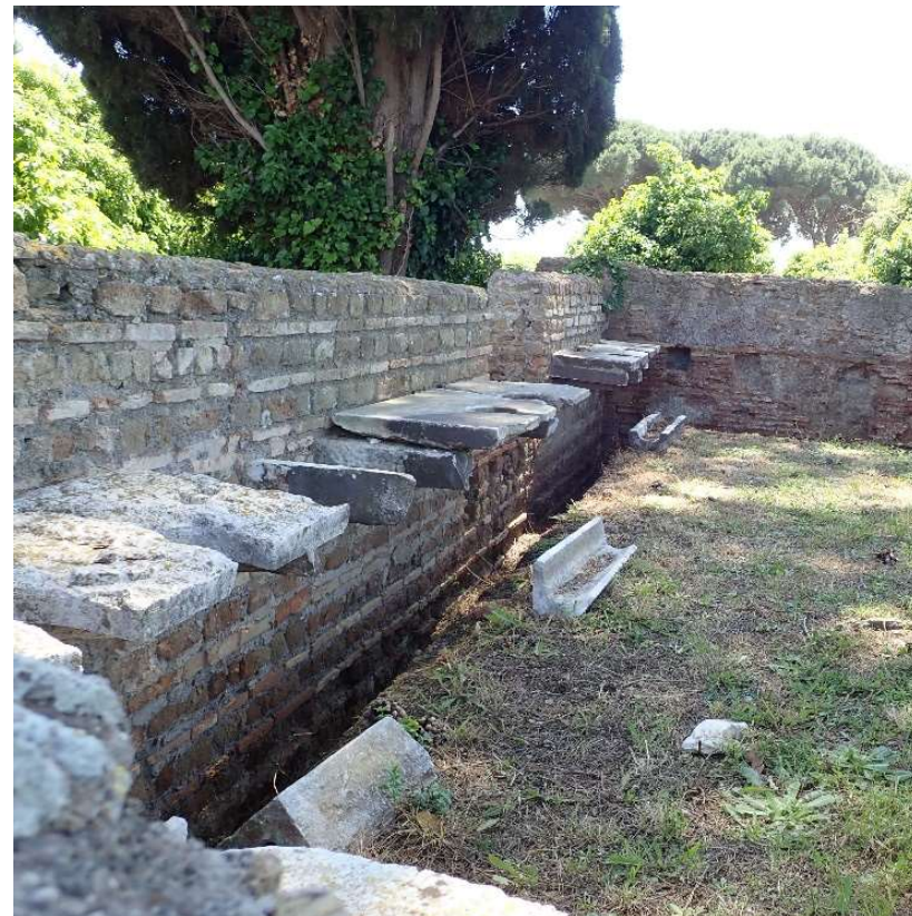
OBR. 9. Verejné latríny v Ostii. Pod mramorovými sedadlami prúdila voda, ktorá neustále odvádzala splašky do kanalizácie. Autor: M. Daňová
