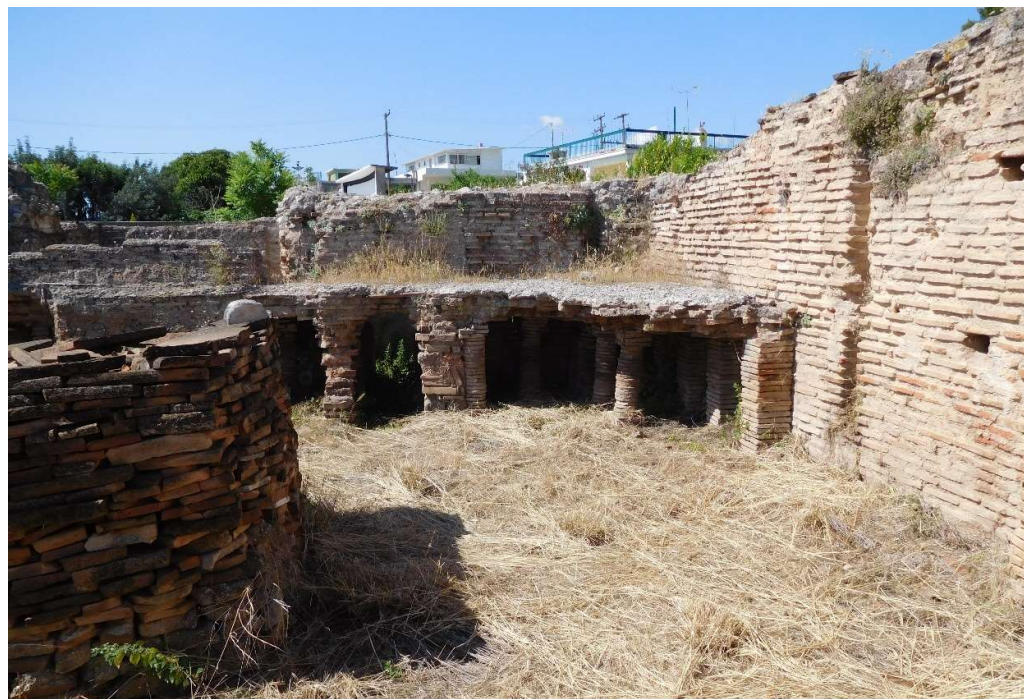
OBR. 60. Hypocaustum kúpeľov v Argu, pristavané k Serapeiu v 2. storočí po Kr. Foto: L. Nováková.
