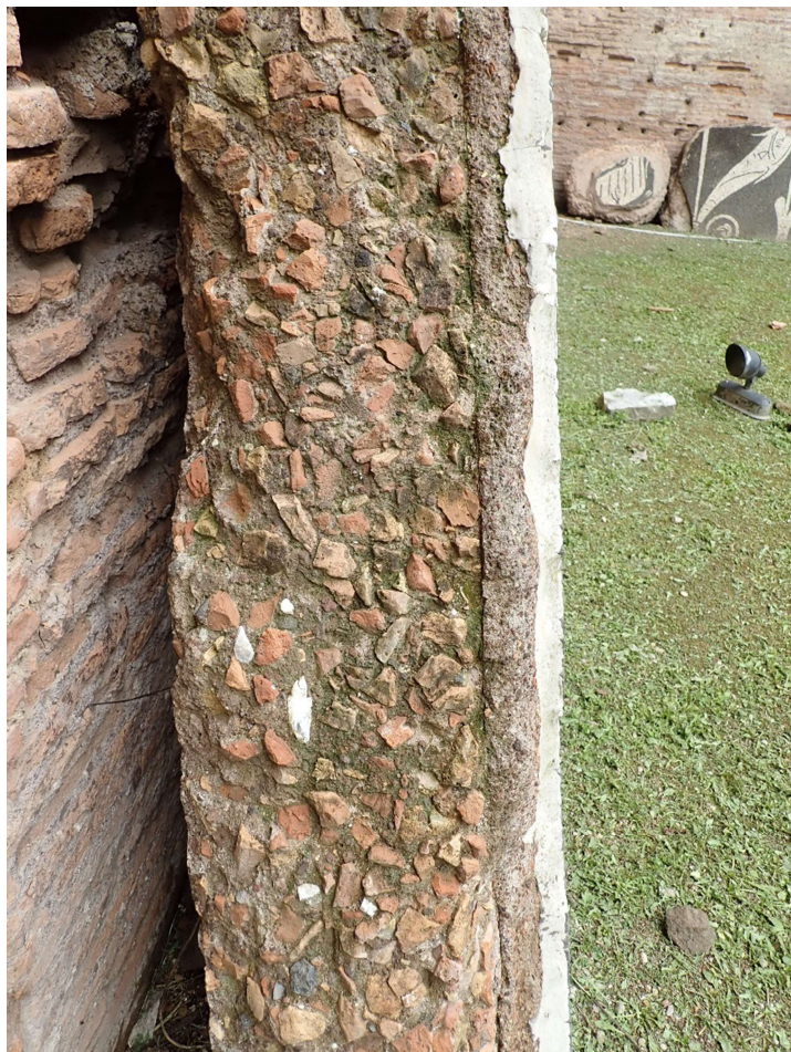
OBR. 30. Caracallove kúpele sú skvelou príležitosťou na štúdium architektonických techník a riešení. Pre návštevníkov sú čiastočne prístupné aj mozaiky, vrátane tejto (opretej o stenu kúpeľov). V profile je možné vidieť jednotlivé vrstvy uloženia podláh. Autor: M. Daňová
