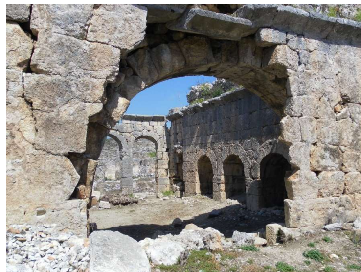
OBR. 57. Malé kúpele v Tlos, postavené v 1. storočí po Kr. Stavba, obnovená po zemetrasení v roku 141 po Kr., neskôr slúžila ako byzantský kostol. Foto: L. Nováková.
