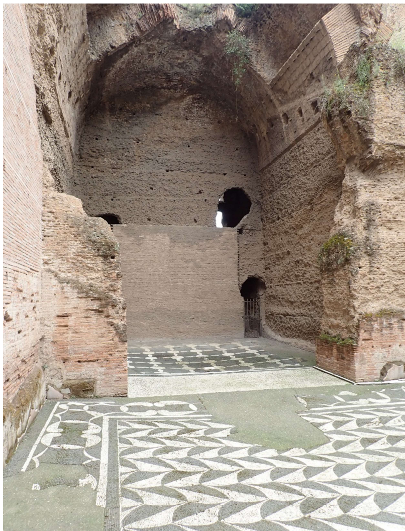
OBR. 29. Pohľad do jednej z bočných miestností (časť 15Z) v blízkosti západnej palaestry. Podlaha je zdobená dvojfarebnou mozaikou a na tehlových klenbách sú otvory po nezachovaných architektonických prvkoch. Autor: M. Daňová
