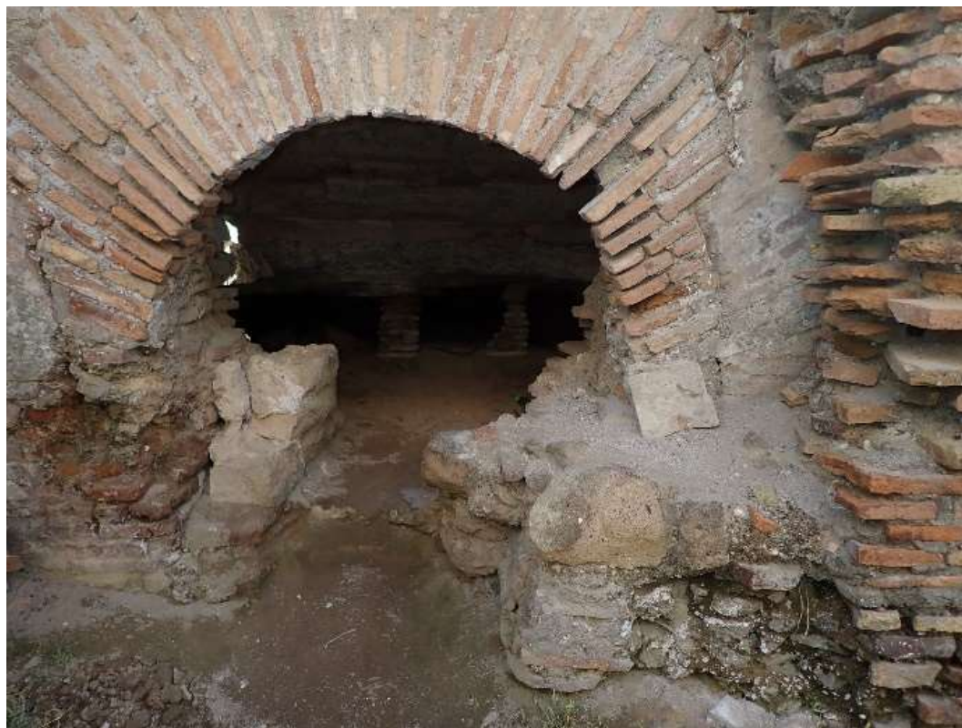
OBR. 5. Praefurnium a pohľad do hypocausta Neptúnových kúpeľov v Ostii. Autor: M. Daňová
